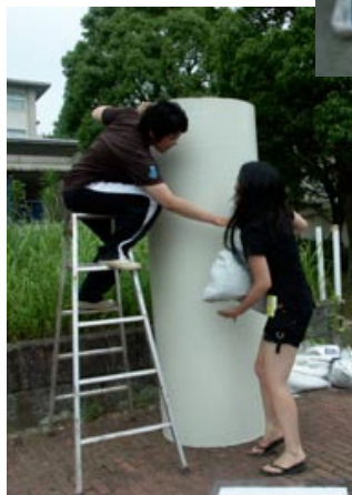
土嚢を入れる。
